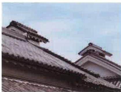
昔の民家には囲炉裏の煙や御勝手から出る煮炊きの熱や水蒸気を排出する『煙出し屋根』がありました。熱は屋根上部の小屋裏からたまつてゆきます。対照的に床下には真夏でも外気温より 10℃前後低い空気が安定してあります。この冷気を利用して壁の中に空気の道を造り、屋根と床下で生じる温度差から自然な上昇気流が生まれ、緩やかに屋外へ熱を排出することができれば屋根や壁の中に熱を抱えず、室内への影響が小さくて済みますからエアコンの力を最小限にすることができるのです。
